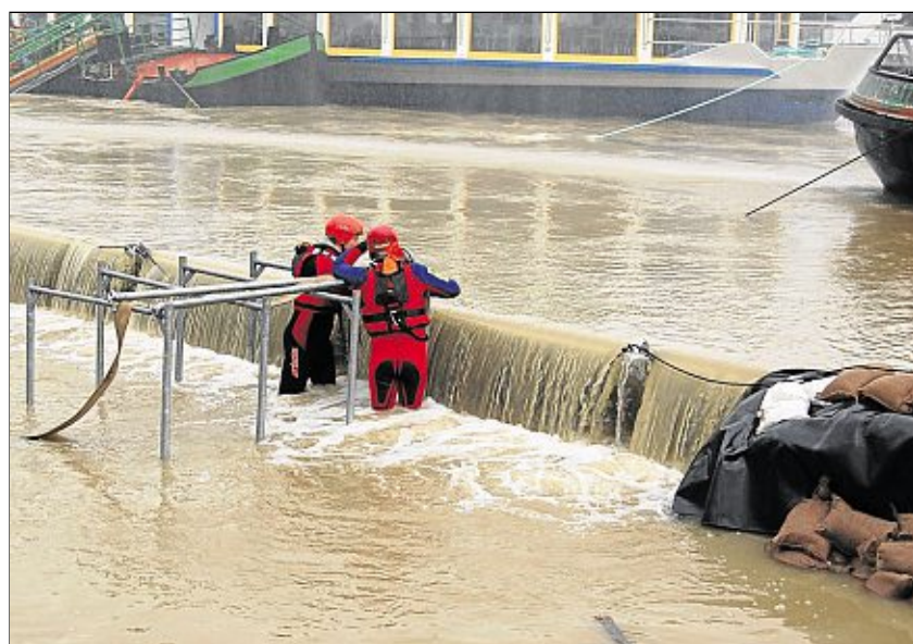
Mit dem leistungsstarken Aggregat des THW Schwandorf wurden die Pumpen hinter den Spundwänden betrieben. Doch dann floss so viel Wasser über die Wände, dass die Wertstraße abgegeben werden musste.
