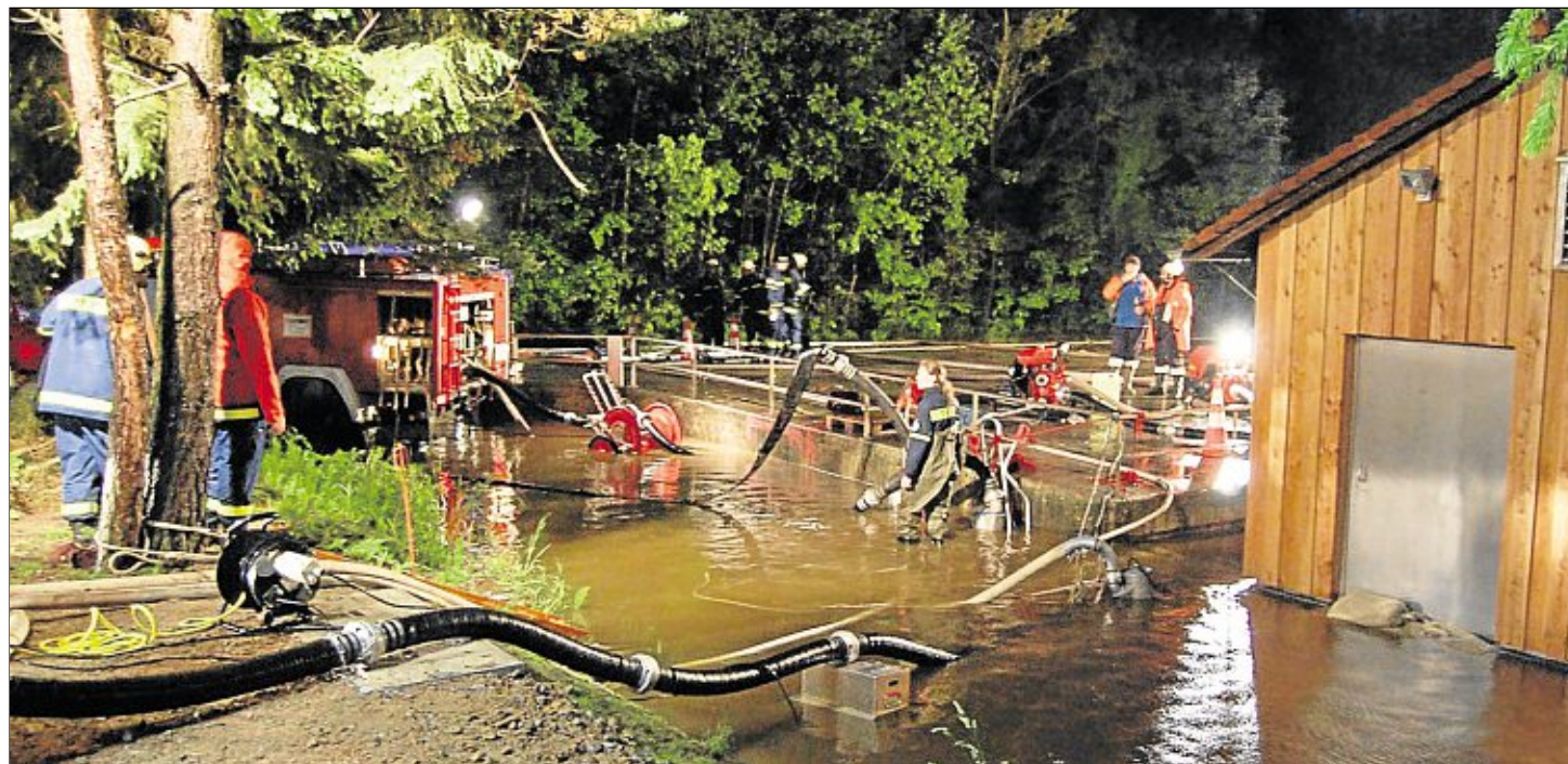
Steinberg am See: Eine zentrale Pumpstation der Kanalisation drohte durch das Hochwassers auszufallen.
